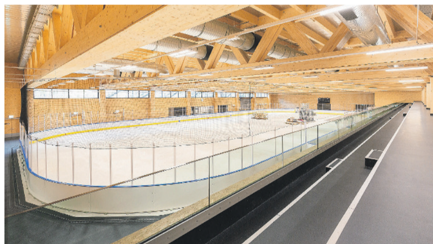
Blick auf das Eisfeld von der Stehtribüne (600 Personen) aus.
